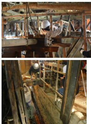
旧水車のクモ手取り外し・心棒外し・底樋調査 2017.12.10-11
