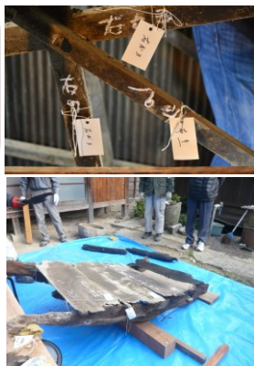
旧水車のクモ手取り外し・心棒外し・底樋調査 2017.12.10-11
