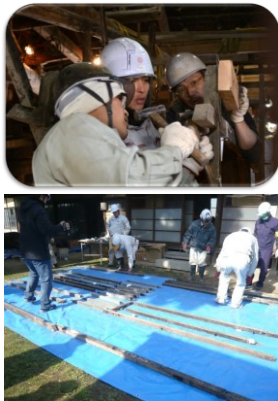
旧水車のクモ手取り外し・心棒外し・底樋調査 2017.12.10-11
