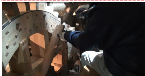
水車の心棒を打ち込み、楔で締め付ける作業。
