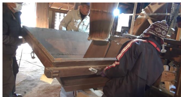
長い漏斗（ロート）の下にあるホッパー（四角錐）の取り付け。
