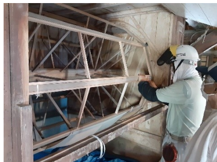
10 角形のガンド木枠を取付け
