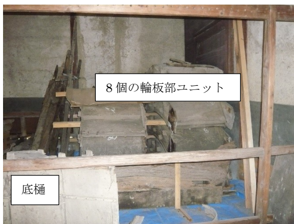
8 個の輪板ユニットと底樋 (下) は別方向から見た輪板
