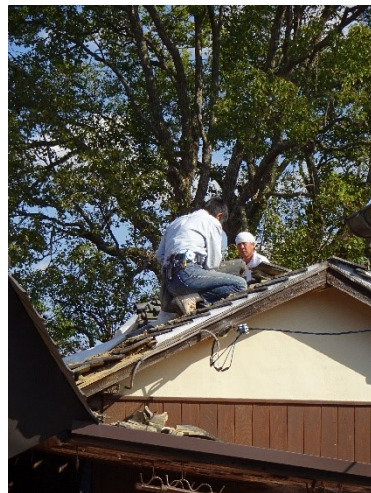
トイレの屋根瓦修繕(請川窯業さん) 北側屋根だけで、丸瓦 170 枚・平瓦 216 枚
