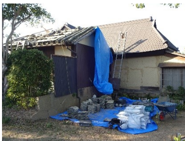
トイレの屋根瓦修繕(請川窯業さん) 北側屋根だけで、丸瓦 170 枚・平瓦 216 枚
