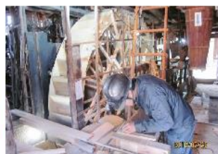
〔水輪取付施工〕
