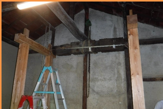
新しい木で太い支柱を建て、重い水車軸を天井近くに設置 準備作業 2021年9月～
