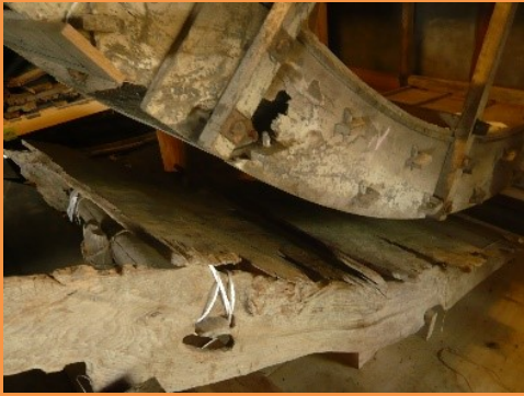
水輪の下にある底樋(そごい)を再現。水路に浸かっていたが、形をとどめていた。材料は松材。
